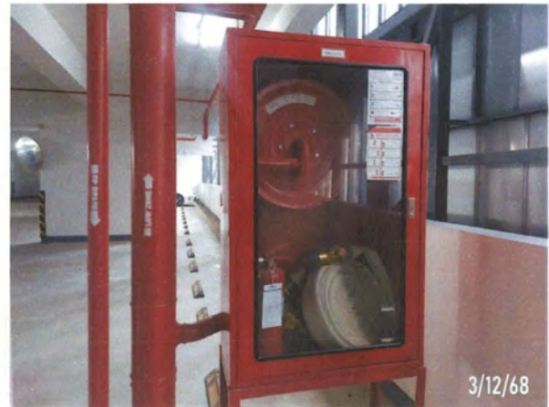
ตู้รับน้ำดับเพลิง (Fire Hose Cabinet)
