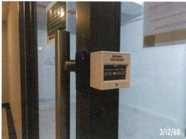
อุปกรณ์ตัดการล๊อคประตูฉุกเฉิน
