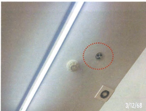
ระบบหัวกระจายน้ำดับเพลิงอัตโนมัติ (Sprinkler System)
