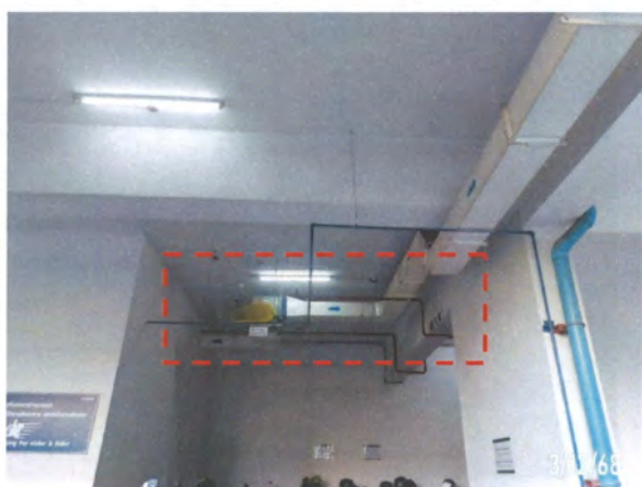
รูปที่ 2-48 ระบบระบายอากาศบริเวณพื้นที่จอดรถ
