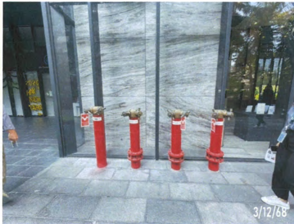
หัวรับน้ำดับเพลิง (Fire Department Connection)
