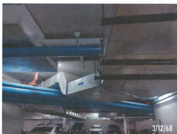
รูปที่ 2-48 ระบบระบายอากาศบริเวณพื้นที่จอดรถ
